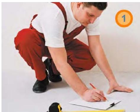
1. Составить чертеж обогреваемой площади, с указанием расположения нагревательных матов, концевой и соединительной муфт, датчика температуры и места подключения к электрической сети. При повреждении греющего кабеля в процессе укладки или в процессе строительных работ это значительно облегчит поиск места повреждения (рис. 1).
