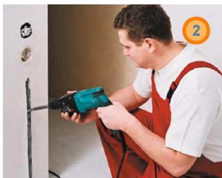
2. В стене и полу прорубить штробу сечением 25 x 25 мм. Она необходима для укладки датчика температуры, холодного соединительного провода и для установки настенной коробки для терморегулятора (рис. 2, 3).
