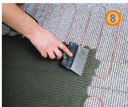
8. Равномерно залить нагревательный мат тонким слоем плиточного клея или иного самовыравнивающегося раствора. Греющий кабель и соединительная муфта должны быть залиты полностью (рис. 8).
