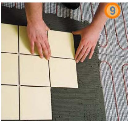
10. Нанести на просохшую поверхность новый слой плиточного клея и уложить кафельную плитку или другое покрытие (рис. 9).
