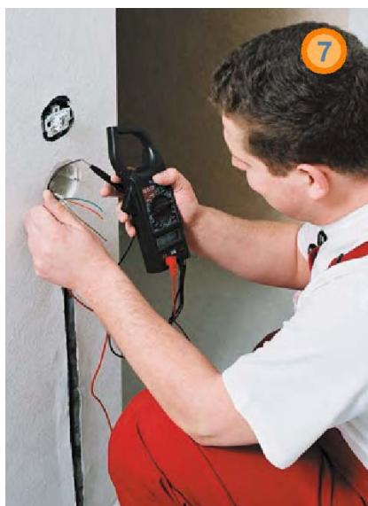
7. После укладки нагревательного мата замерить омическое сопротивление. Омическое сопротивление греющего кабеля должно соответствовать указанному в паспорте на нагревательный мат (рис. 7).
