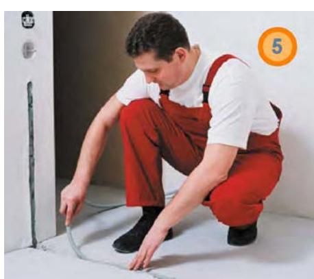
4. Датчик температуры пола поместить в пластмассовую трубку диаметром 20 мм, заглушенную на одном конце для предотвращения попадания внутрь бетона и поместить в штробу, согласно составленному чертежу (рис. 5).
